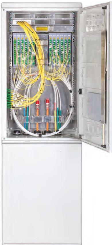
Das Multifunktionsgehäuse für außen ist dauerhaft am Boden befestigt. Schutz der montierten Ausrüstung vor Wetterbedingungen und Zugang von Unbefugten. Permanente Positionierung auf einer unterirdischen Basis, die am Boden befestigt ist. Im Dach sind Transportösen montiert. Der Verteiler bietet ein hochwertiges, integriertes, modulares optisches Management zum Terminieren oder Anschließen von optischen Kabeln in Mikrokanälen oder HDPE-Schutzrohren.
